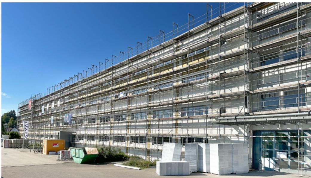
Berge aus Dämmmaterial stapeln sich auf dem großen Parkplatz an der Arbachtalstraße. Das Dach ist gemacht, die neuen Fenster und Türen bereits eingebaut, die Fassade gedämmt.
